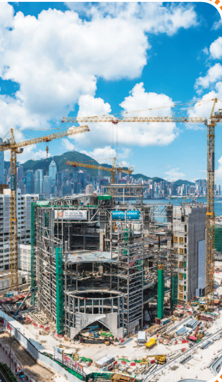
協興建築有限公司承建的西九文化區戲曲中心
