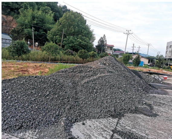
收集廢棄瀝青以回收再用
