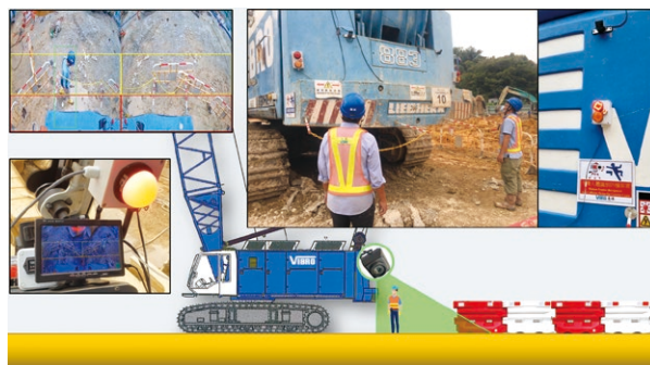
採用危險區域警報系統 以提升地盤安全
