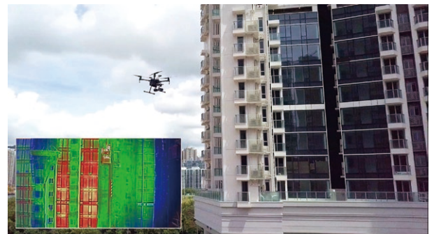
於建築項目應用無人機及熱能顯像技術， 管理工地安全及質量
