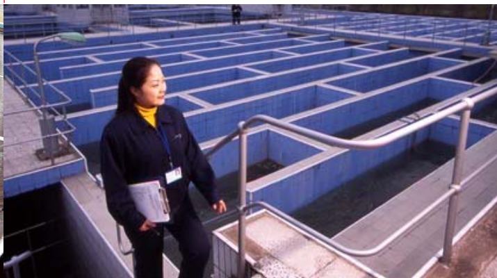
Chongqing Water 重慶水廠
