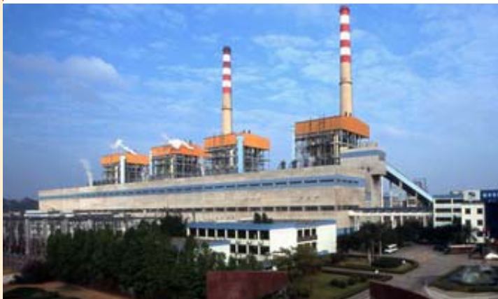
Zhujiang Power Phase I & II 珠江電廠第一及第二期
