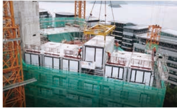
現場組裝在工廠製造的模塊
