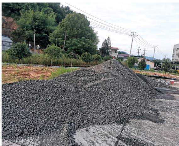
收集廢棄瀝青以回收再用
